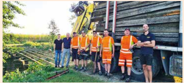
Abtragung der Holzbrücke im Ortsteil Grünau mit der Firma Flucher Transport GmbH (Foto: Marktgemeinde Groß Sankt Florian)
