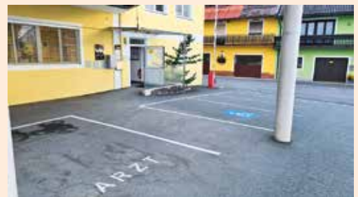
Markierungsarbeiten beim Ärztehaus durch die Firma Bodenmarkierung Pichler (Foto: DI (FH) Moritz Purr)
