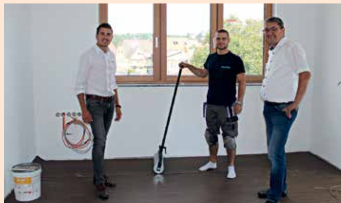
Bodenlegearbeiten in einem der neuen Büros (Foto: Marktgemeinde Groß Sankt Florian)
