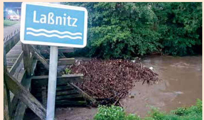
Holzbrücke in Grünau Alle Fotos: FF Groß Sankt Florian
