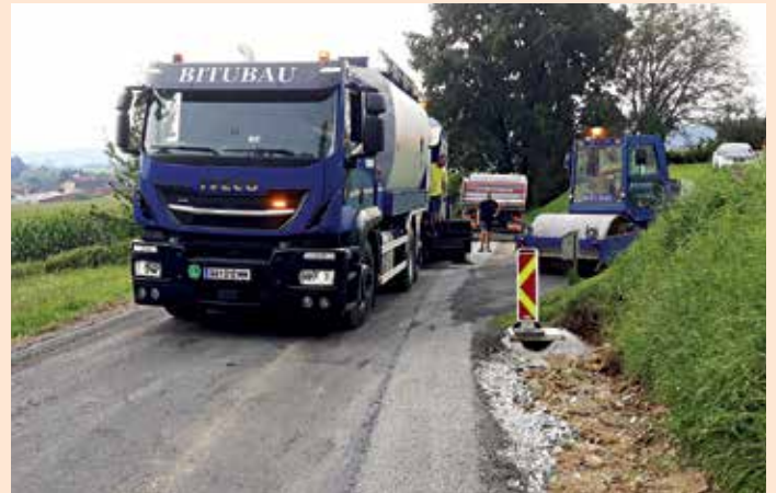
Bankettsanierung in der Katastralgemeinde Vochera (Foto: GR Herbert Jöbstl)
