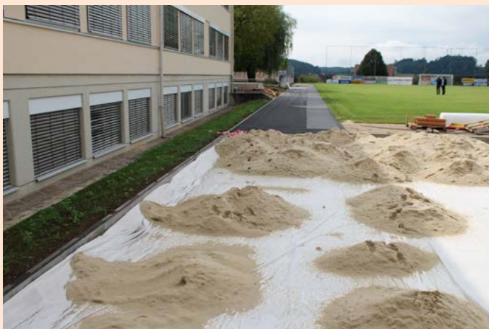
Sanierungsarbeiten der Außenanlagen (Foto: Mgde. Groß St. Florian)
