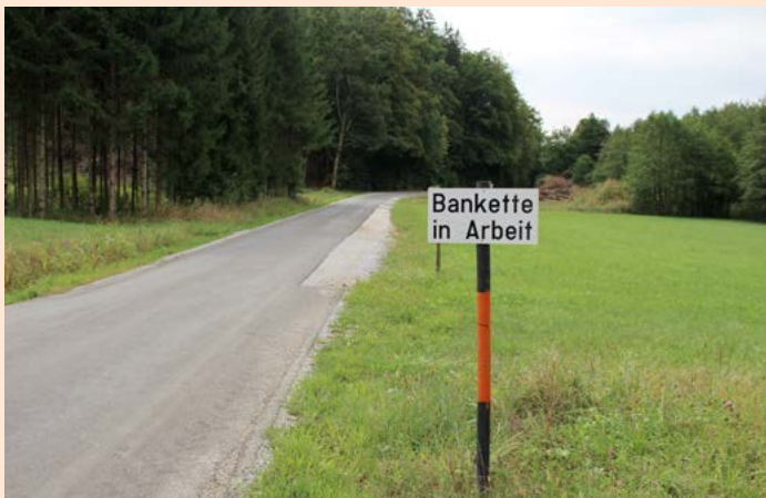
Bankettarbeiten in Kraubath (Foto: Mgde. Groß St. Florian)
