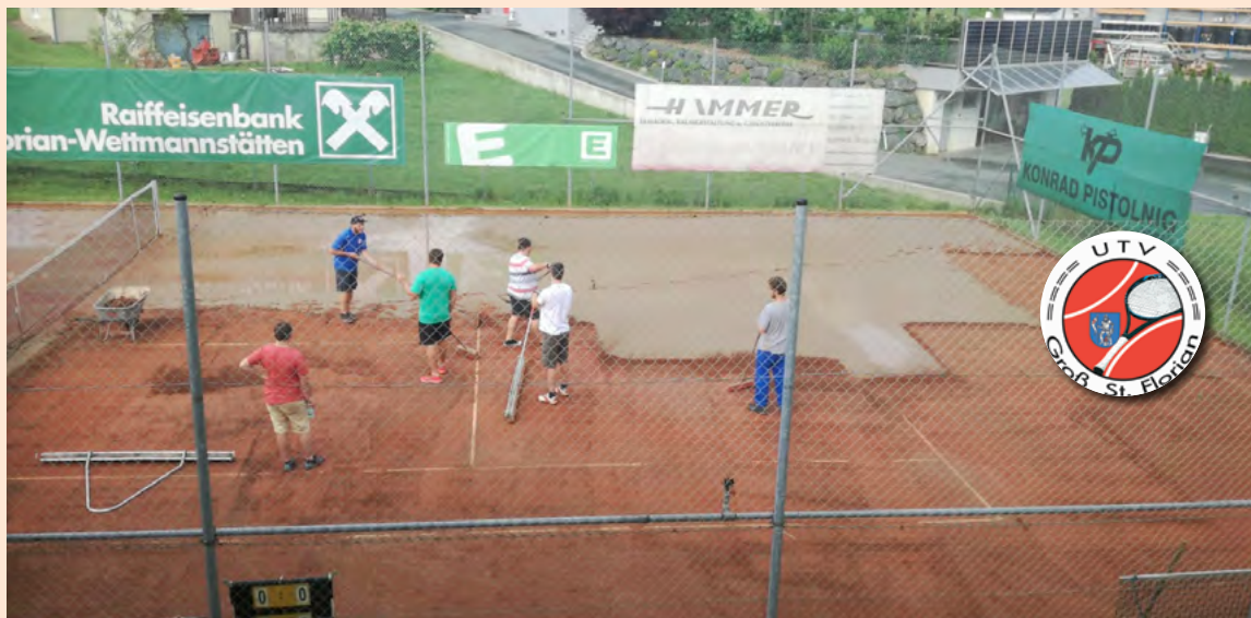
Fleißige Platzsanierer bei ihrer Arbeit nach dem Unwetterschaden (Foto: Klaus Puntigam)
