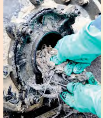
Die Reinigungsarbeiten sind sehr aufwendig
