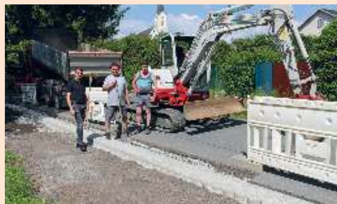
Fertigstellungsarbeiten beim neuen Gehweg in der Sonnenstraße (Foto: Marktgemeinde Groß Sankt Florian)
