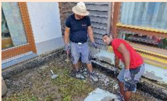
Sanierungsarbeiten des Außenbereichs beim Kindergarten Unterbergla durch die Firma Fadil-Bau GmbH (Foto: Marktgemeinde Groß Sankt Florian)
