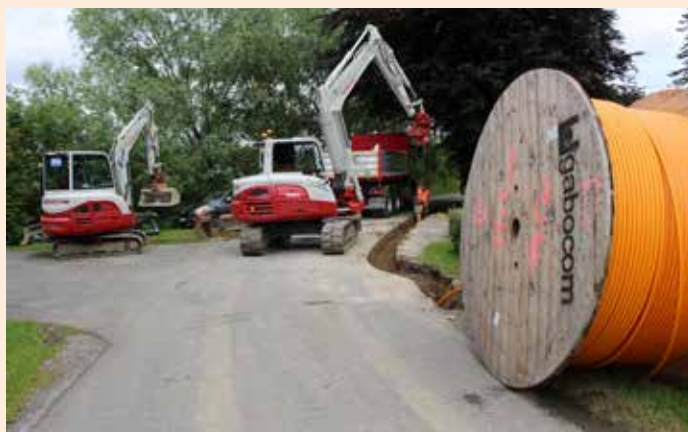
Breitbandausbau in Kelzen – die Arbeiten gehen zügig voran (Foto: Marktgemeinde Groß Sankt Florian)
