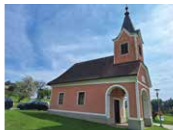
Die Dorfkapelle im Zustand vor den Renovierungstätigkeiten
