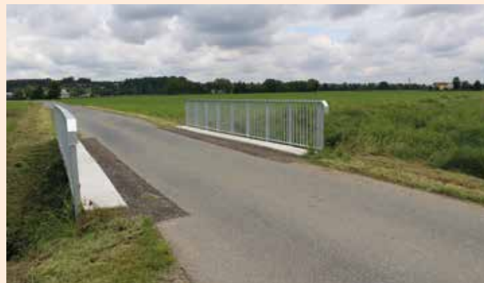
Eine sanierte Vorfluterbrücke in der Lebinggleinzstraße
