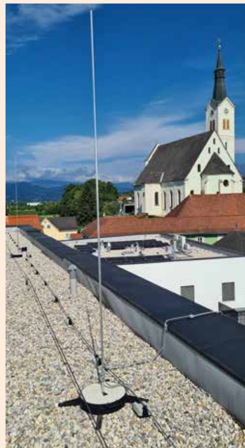
Blitzschutzanlage am Dach des Rathauses (Foto: Marktgemeinde Groß Sankt Florian)
