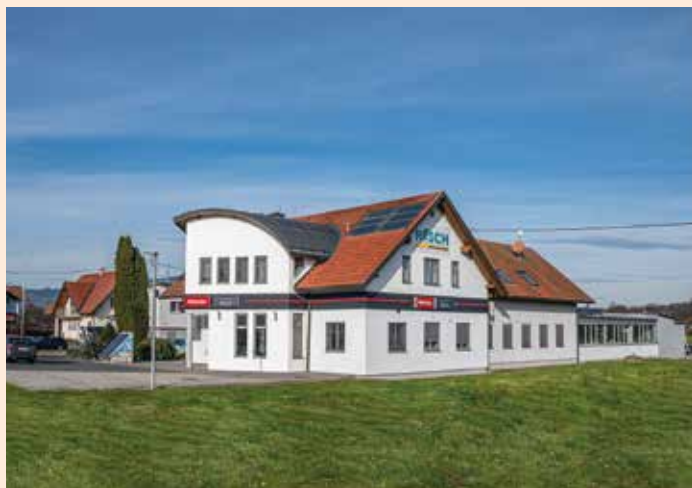
Firmengebäude: Resch Elektrotechnik GmbH und Miele-Center Resch (Foto: fliegendeKamera – Christian Freydl)
