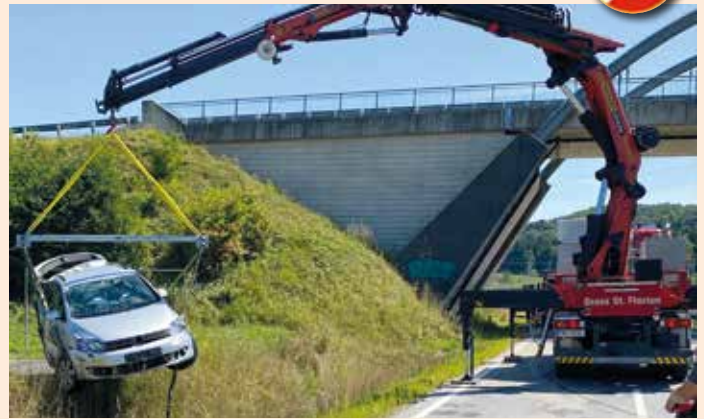
PKW-Bergung mittels LKWA-Kran
