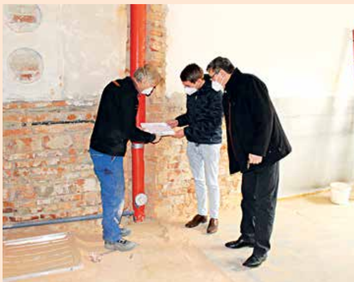
Besprechung auf der Baustelle mit Installateur Josef Painsi (Foto: Marktgemeinde Groß Sankt Florian)
