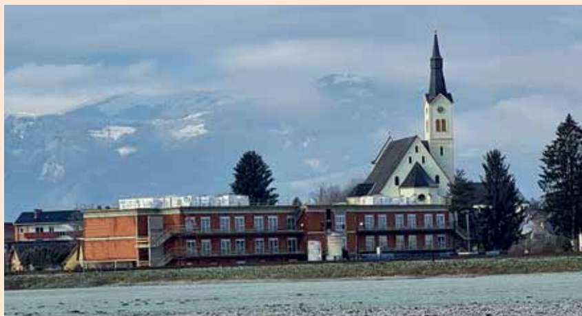
Baufortschritt beim neuen Pflegeheim in Groß Sankt Florian (Foto: Pflege mit Herz)
