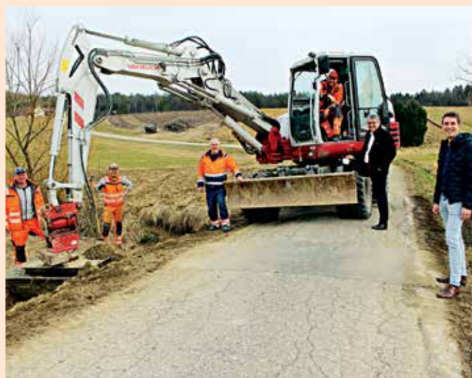
Unser Bagger unterwegs bei Grabenreinigungsarbeiten in der KG Michlgleinz (Foto: Marktgemeinde Groß Sankt Florian)
