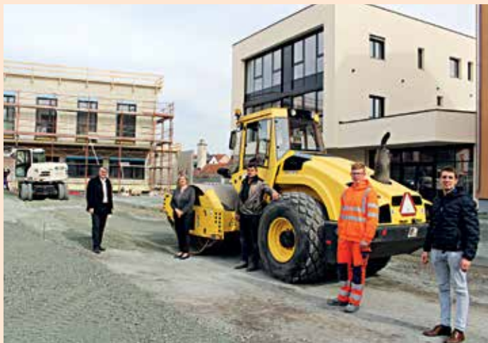
Die Arbeiten wurden von der bauausführenden Firma Swietelsky aus Groß Sankt Florian wieder aufgenommen (Foto: Marktgemeinde Groß Sankt Florian)
