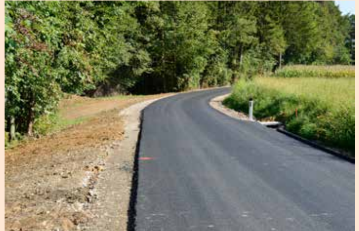
Die Sanierungsarbeiten sind abgeschlossen
