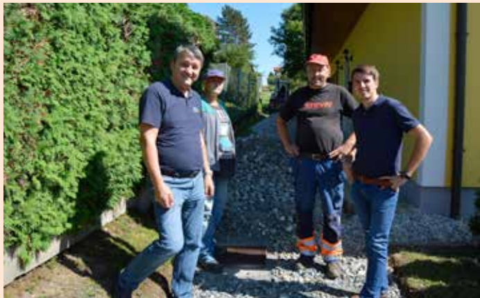
Die Baustelle beim Angerweg ist voll im Gange
