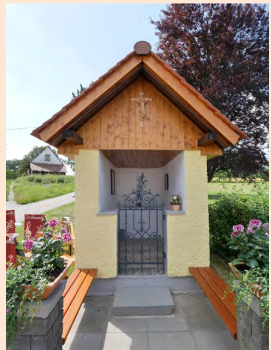
Die neu renovierte Kremser-Kapelle in Unterbergla
