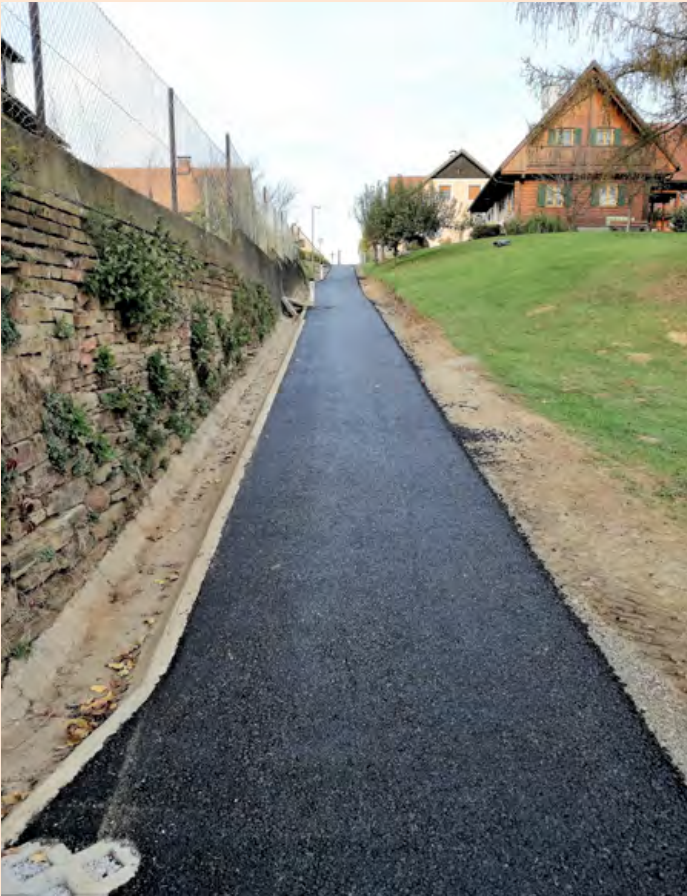
Die Asphaltierungsarbeiten sind beim Gehweg Richtung Petzelsdorf abgeschlossen
