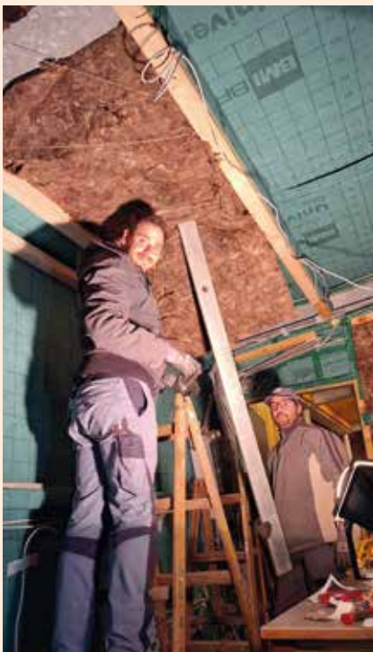
Dämmung in der Kantine
