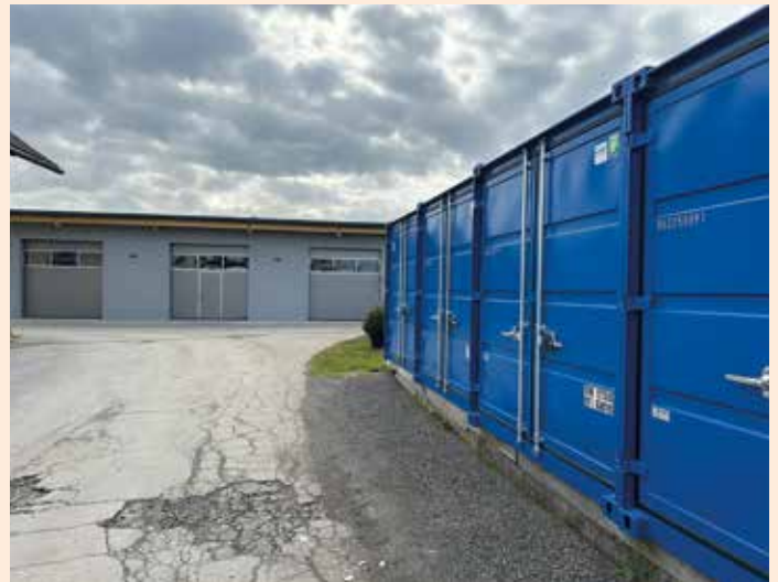
Lagerhallen- und Boxen am Betriebsgelände (Foto: Mag. Jürgen Stock)
