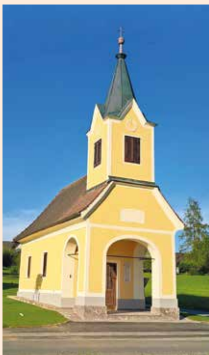
Die neue renovierte Dorfkapelle in Michlgleinz (Foto: Thomas Jauk)
